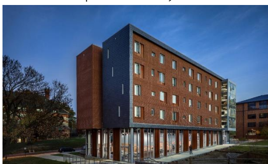
ภาพที่ 2.7 แสดงภาพอาคาร Living and Learning Residence Hall 6 (LLRH6) ที่มา : https://surl.li/hjmgngj
