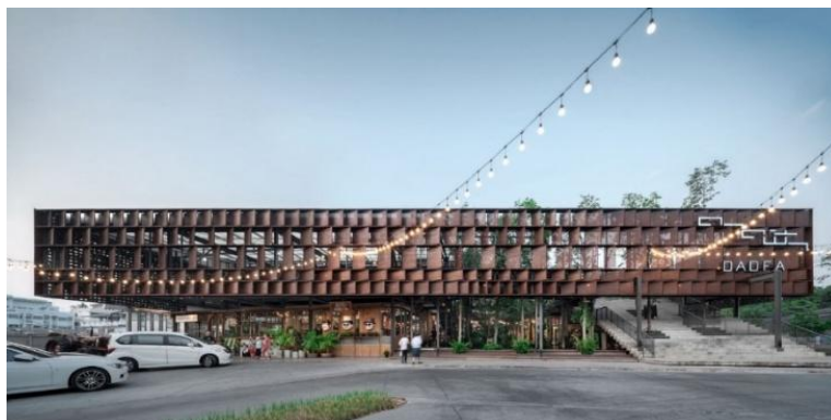
ภาพที่ 2.8 แสดงภาพอาคารดาดฟ้า
