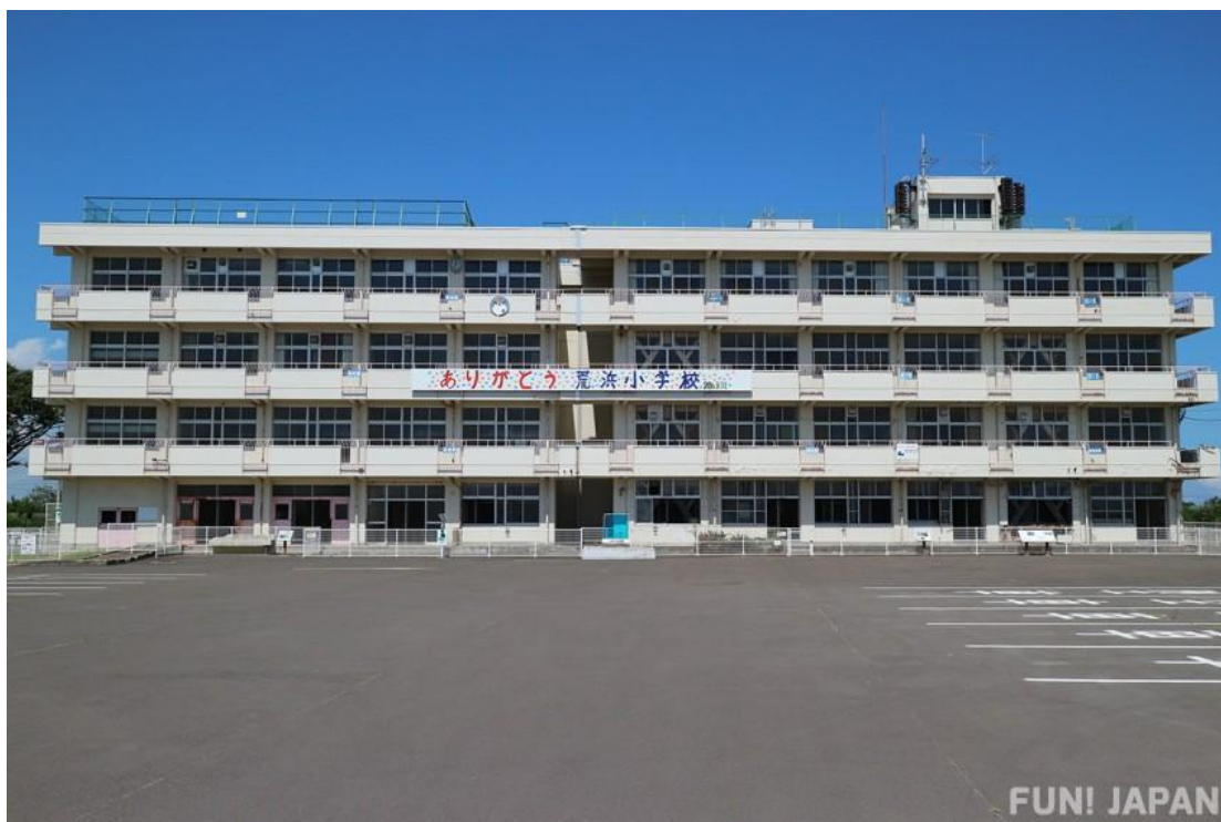
ภาพที่ 2.17 แสดงภาพภายนอกของ Arahama Elementary School, Sendai, Japan ที่มา : Arahama Elementary School. (2011–ปัจจุบัน). Sendai, Miyagi, Japan.
