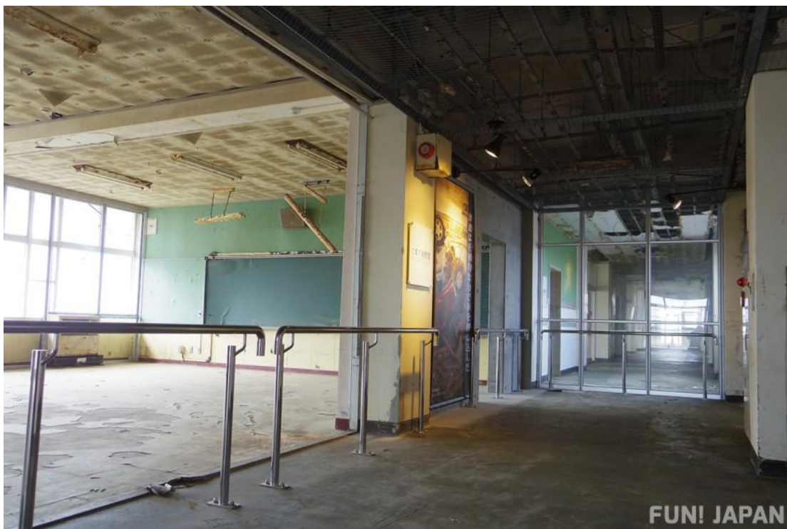
ภาพที่ 2.19 แสดงภาพภายนอกในของ Arahama Elementary School, Sendai, Japan
